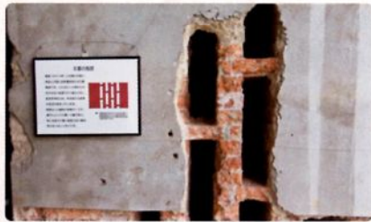
▲倉庫の五重の複壁
