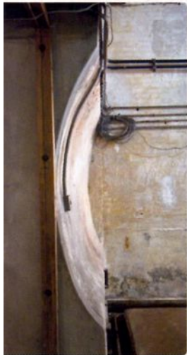
▲倉庫の壁面にある 木製樽の跡
